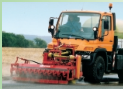
FKM med jordløsner og Højtryksanlæg.
