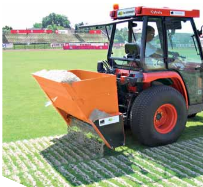
Udlægning af sand på sportspladser
